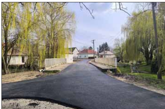
Aszfaltburkolatot kapott a Fülöpsziget utca
