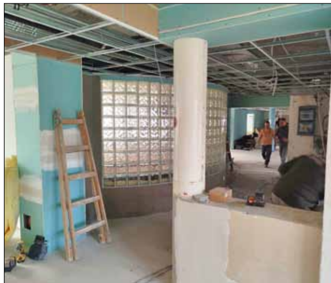
A Thermál Szálló „A” épületének felújítása hamarosan befejeződik
