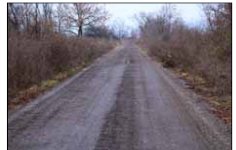
A Dóci út a felújításnak köszönhetően könnyebben járható lett
